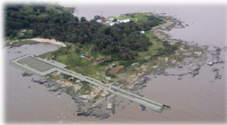
Transmarine pipeline (Uruguay)
